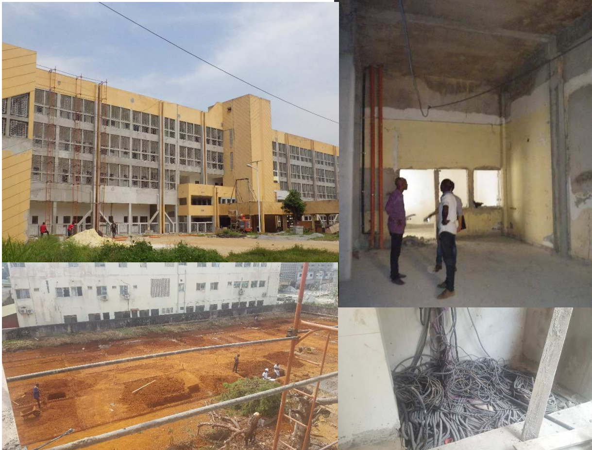
Rénovation de la pédiatrie et la maternité, chantier de l'hôpital de Donka- Conakry
